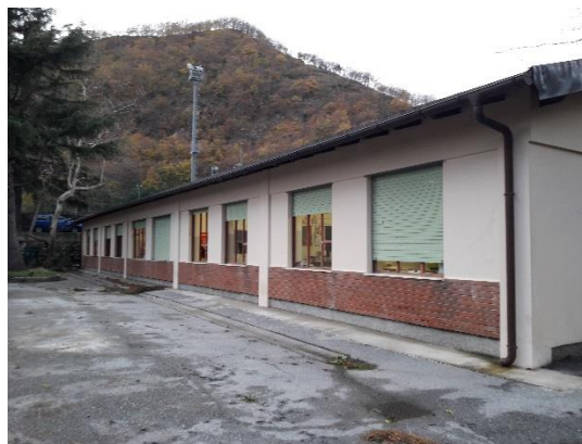
Figura 1.1 - Vista della facciata esposta a sud
