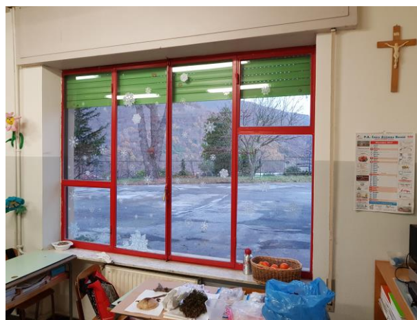
Figura 8.5 - Particolare dei serramenti esistenti
