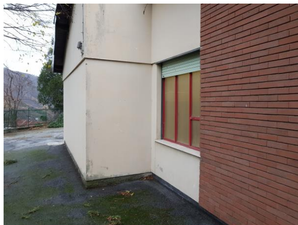
Figura 4.1 - Particolare della porzione di involucro opaco intonacato e con mattone "a vista".
