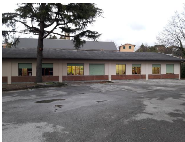
Figura 8.3 - Particolare della copertura
