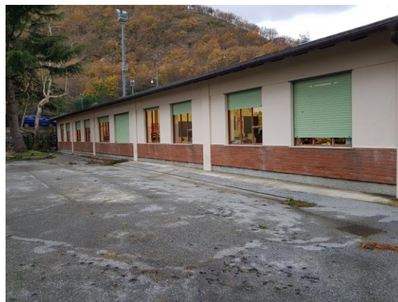
Figura 8.1 - Particolare della muratura esterna
