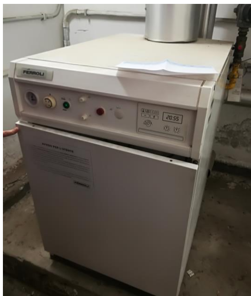
Figura 4.10 - Particolare della caldaia Ferroli Pegasus F2 68
